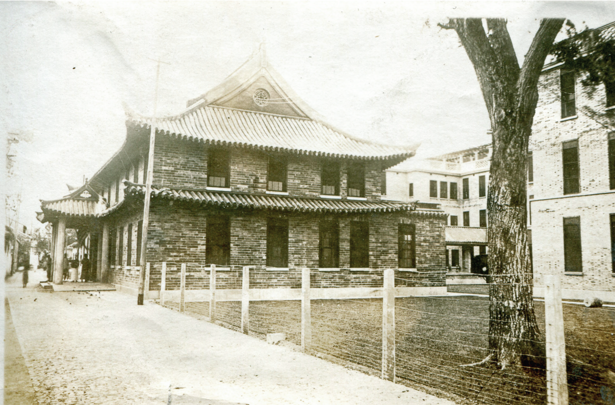
博习医院“金砖”门诊楼
