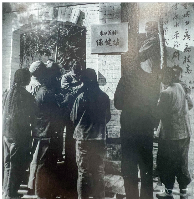
▲曾经的东四义村保健站,是我国农村地区最早建立的保健站之一。 东四义村村委会供图
