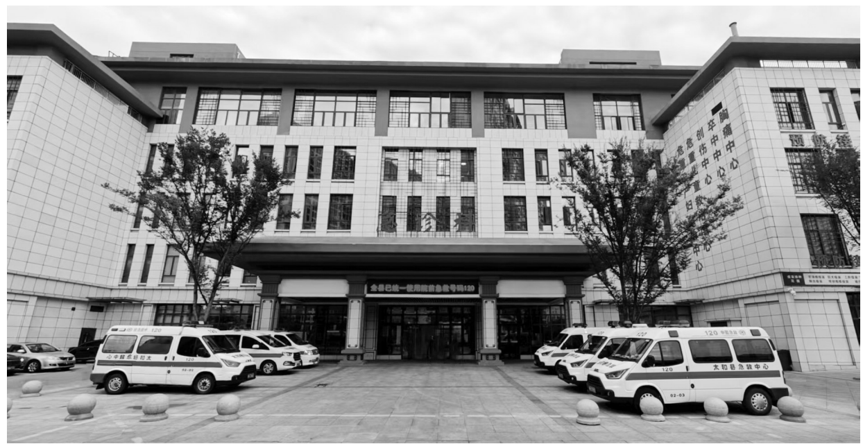
太和县中医院急诊急救综合大楼
