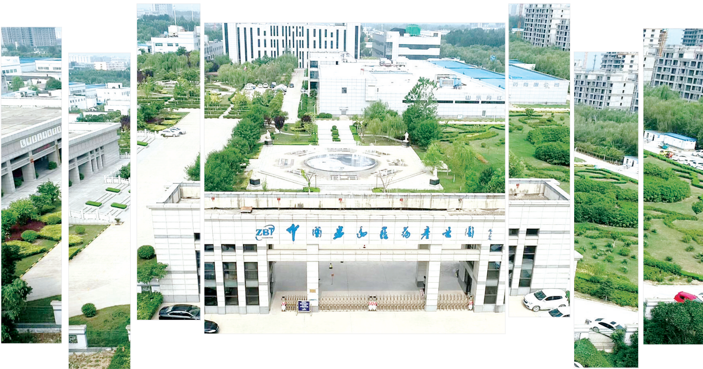
山东步长制药股份有限公司医药工业园
