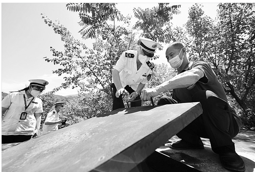
管理员打开蓄水池口。
