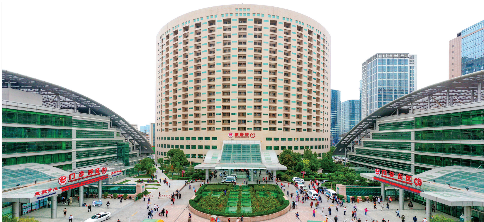
河南省人民医院主院区病房楼
